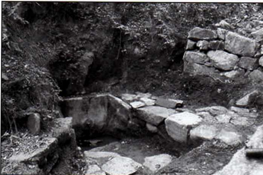
Estat actual de la font, un cop acabada la restauració.
